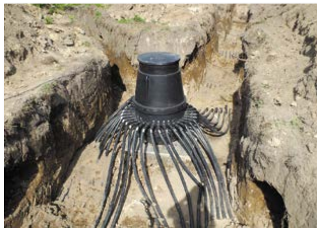
Odwiert pod sondę głębinową (przedszkole w Gwiazdowie) Fot. Gmina Sławno
