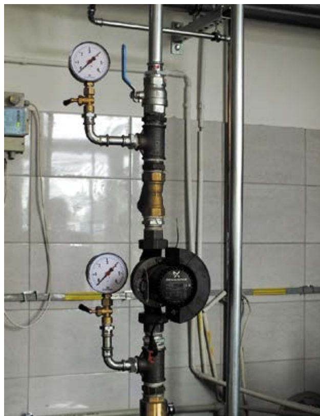
Pomiary podczas montażu pompy ciepła
