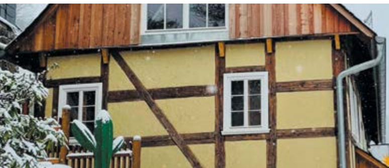
Dom w Saksonii (Niemcy) z pompą ciepła typu solanka/woda. Więcej informacji o projekcie w [1]
